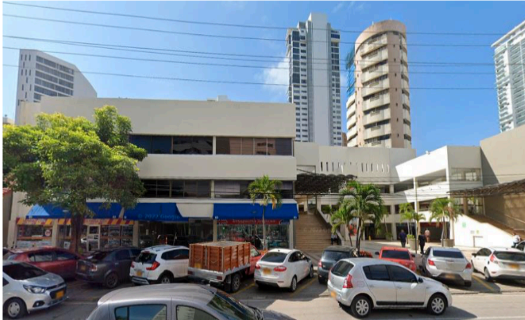
Imagen 5: Centro Comercial Bocagrande: Edificación de tres plantas con azotea en concreto: Contacto: Carlos Bula, celular No. 318-5231815
